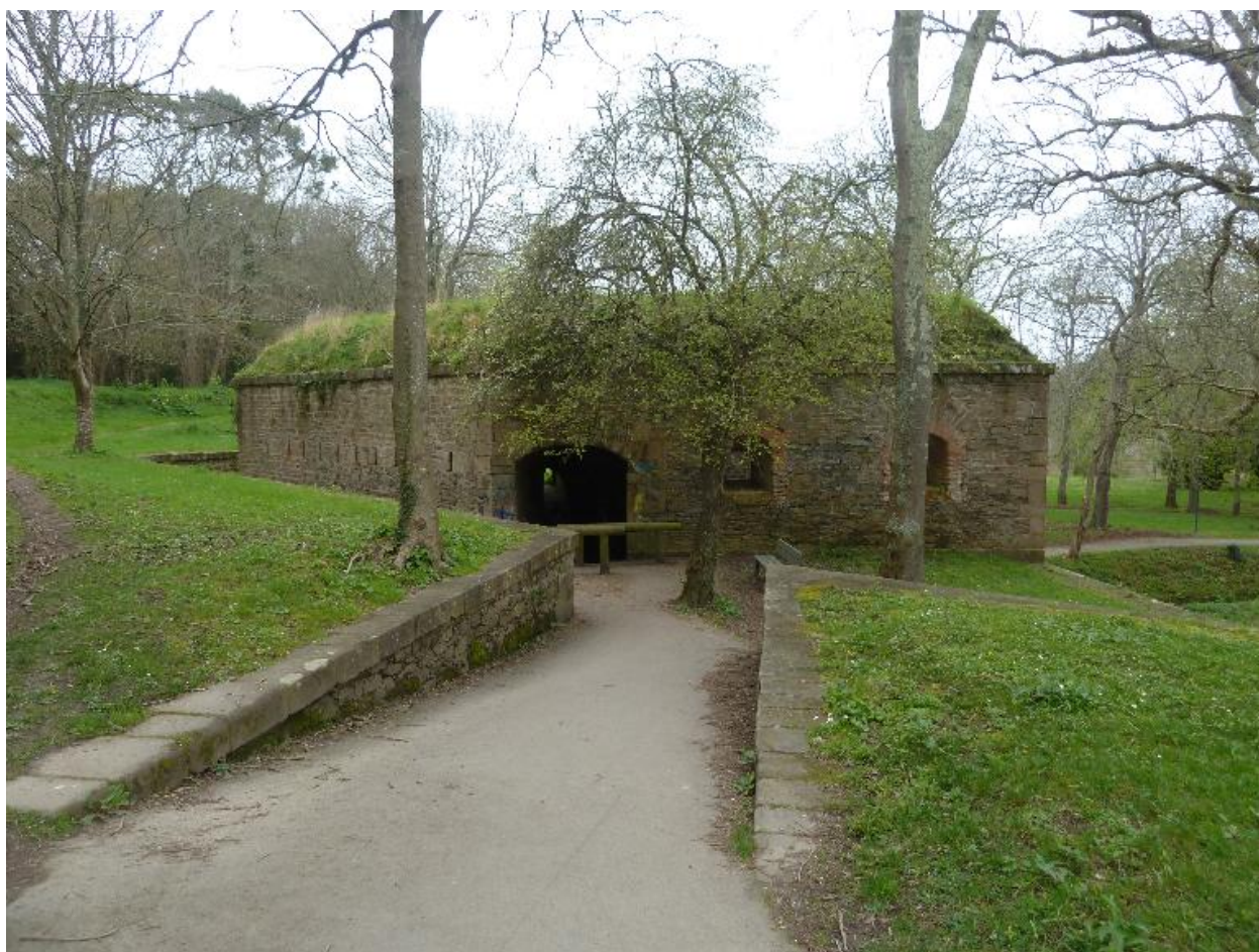
Le Palais, enceinte urbaine, réduit G, face et flanc de gauche.
