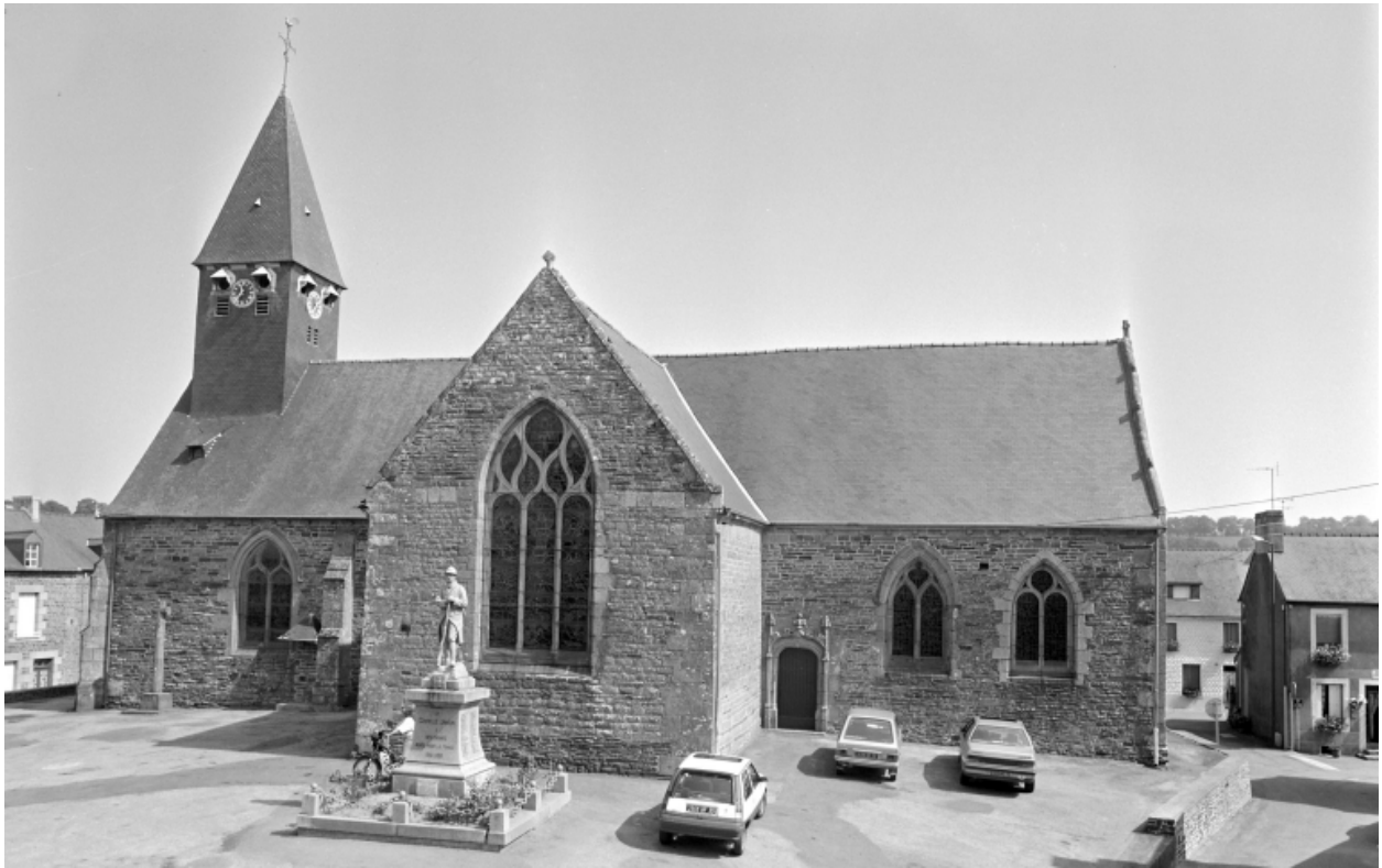
Elévation Sud : vue générale
