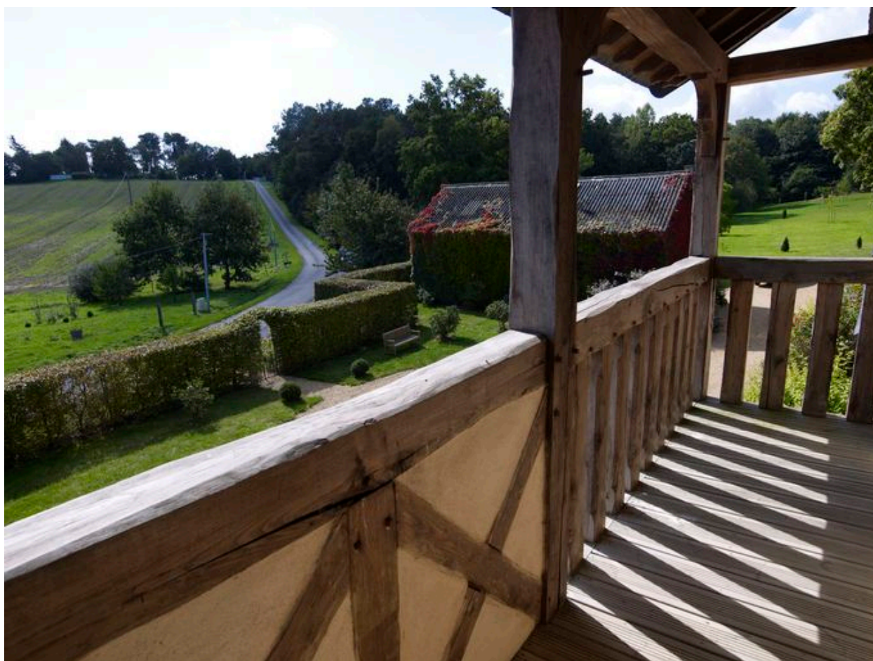
Manoir, logis : coursière en encorbellement (état en 2011)
