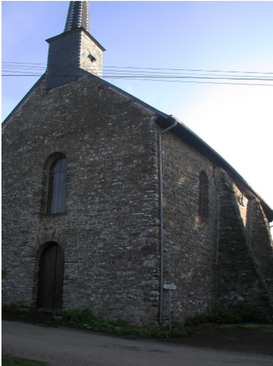
Vue partielle sud ouest
