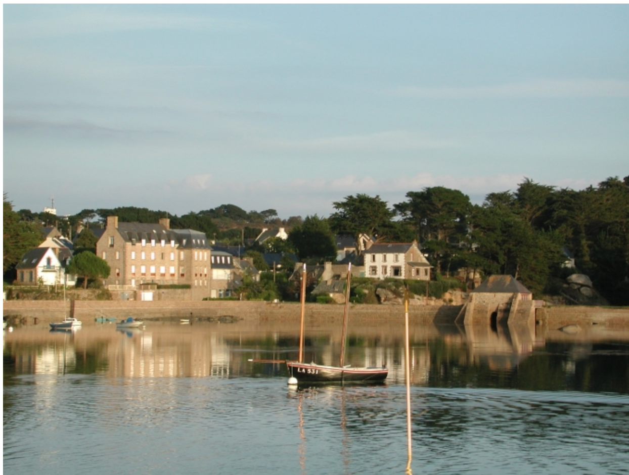
Vue générale du quai Bellevue en limite de la chaussée du moulin à marée
