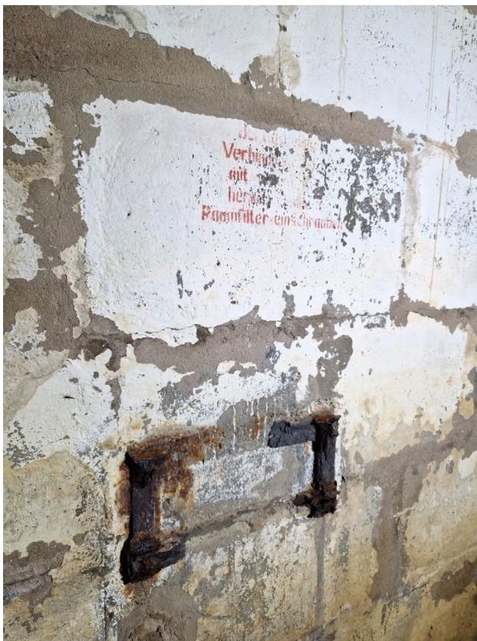
Vue intérieure : salle de garde est, emplacement du ventilateur et marquage en allemand
