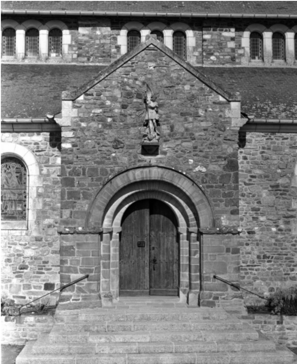
Elévation sud, porte ; vue générale
