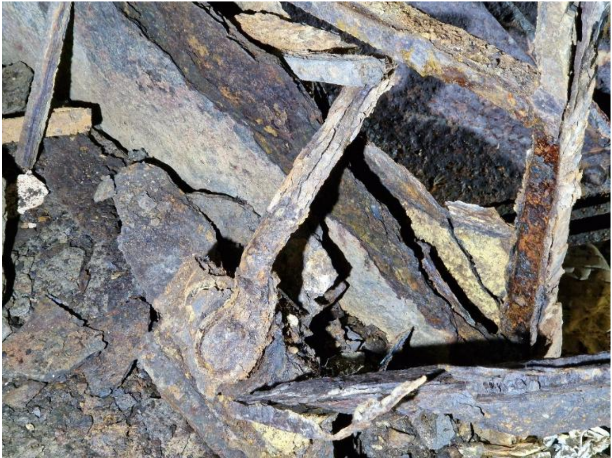
Vue intérieure : salle de garde ouest, vestiges de la porte de l'accès sud
