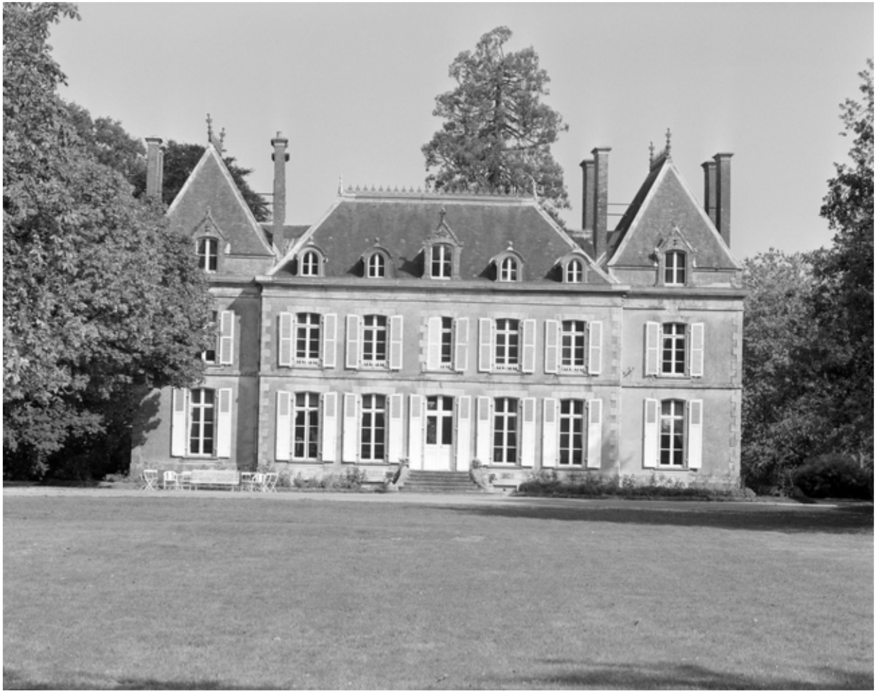
Château, élévation sud, vue générale.
