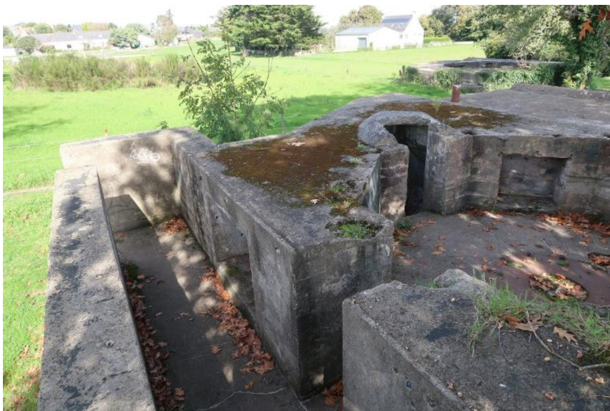
Vue de l'entrée et de la cuve du télémètre
