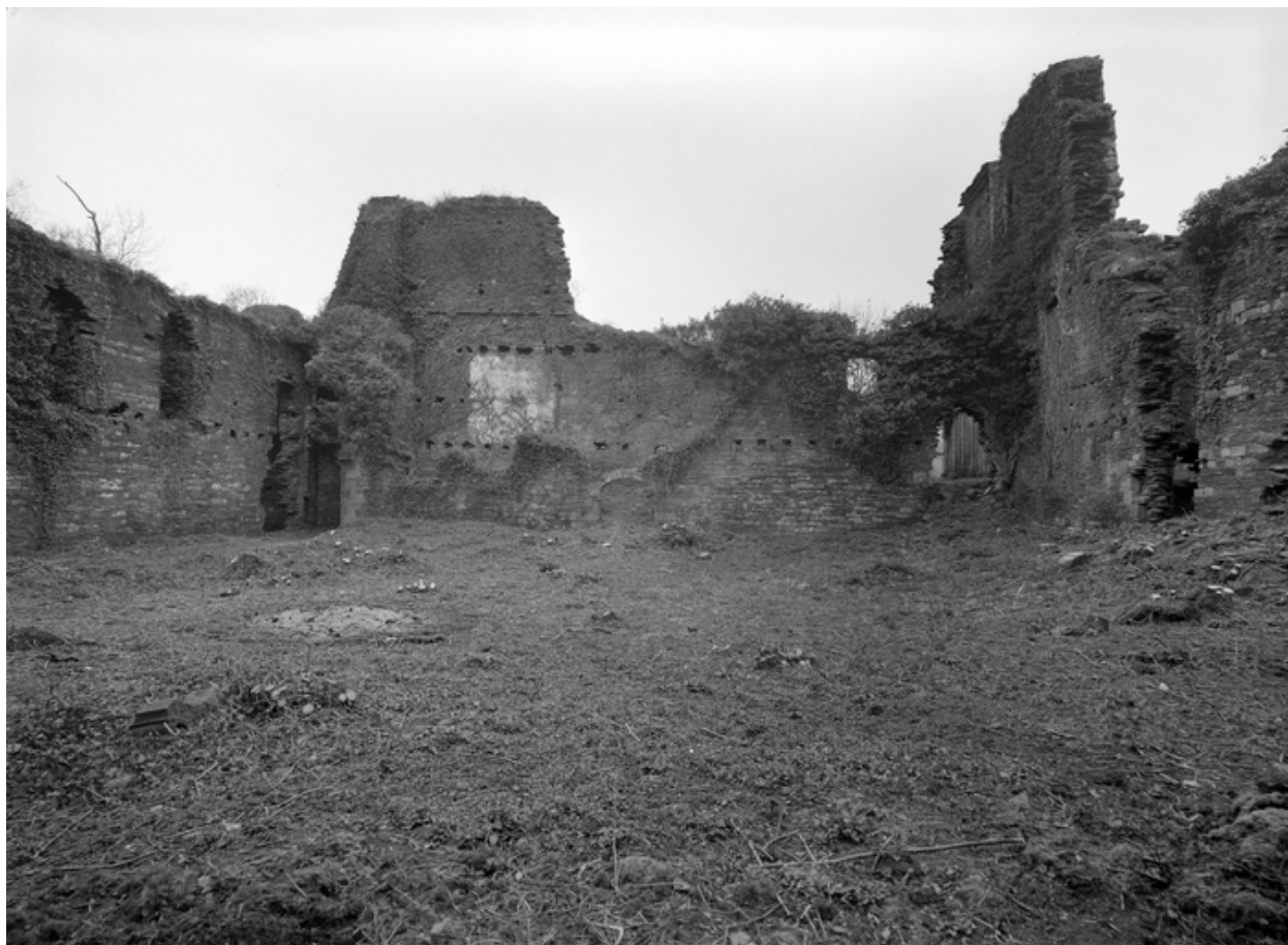
Cloître : vue intérieure prise vers le Nord (état en 1977).
