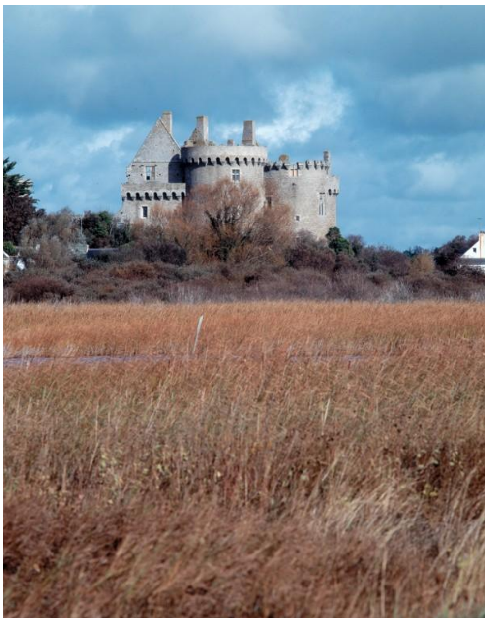
Château fort, vue sud-est.
