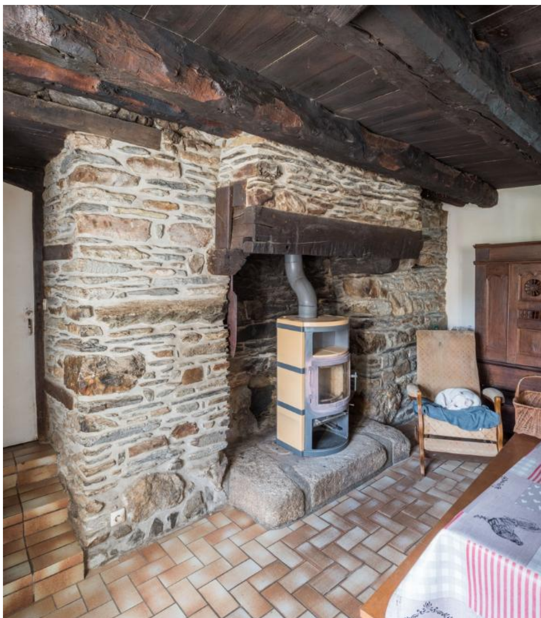
Logis-étable fin 18e ou début 19e siècle. Cheminée de la salle. Vue générale
