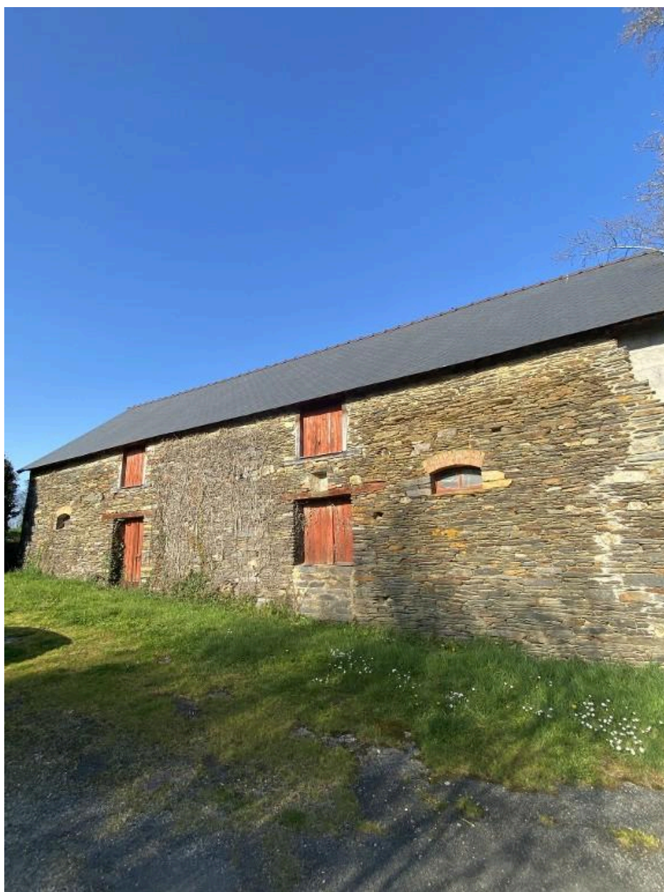
Corps de ferme, vue sud-ouest.
