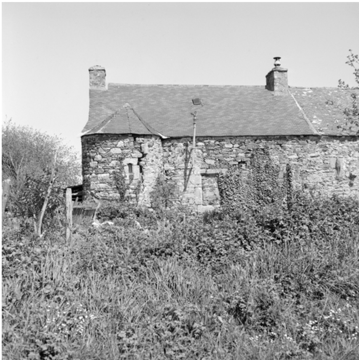
Keriallain - Façade postérieure : vue générale (état en 1974).
