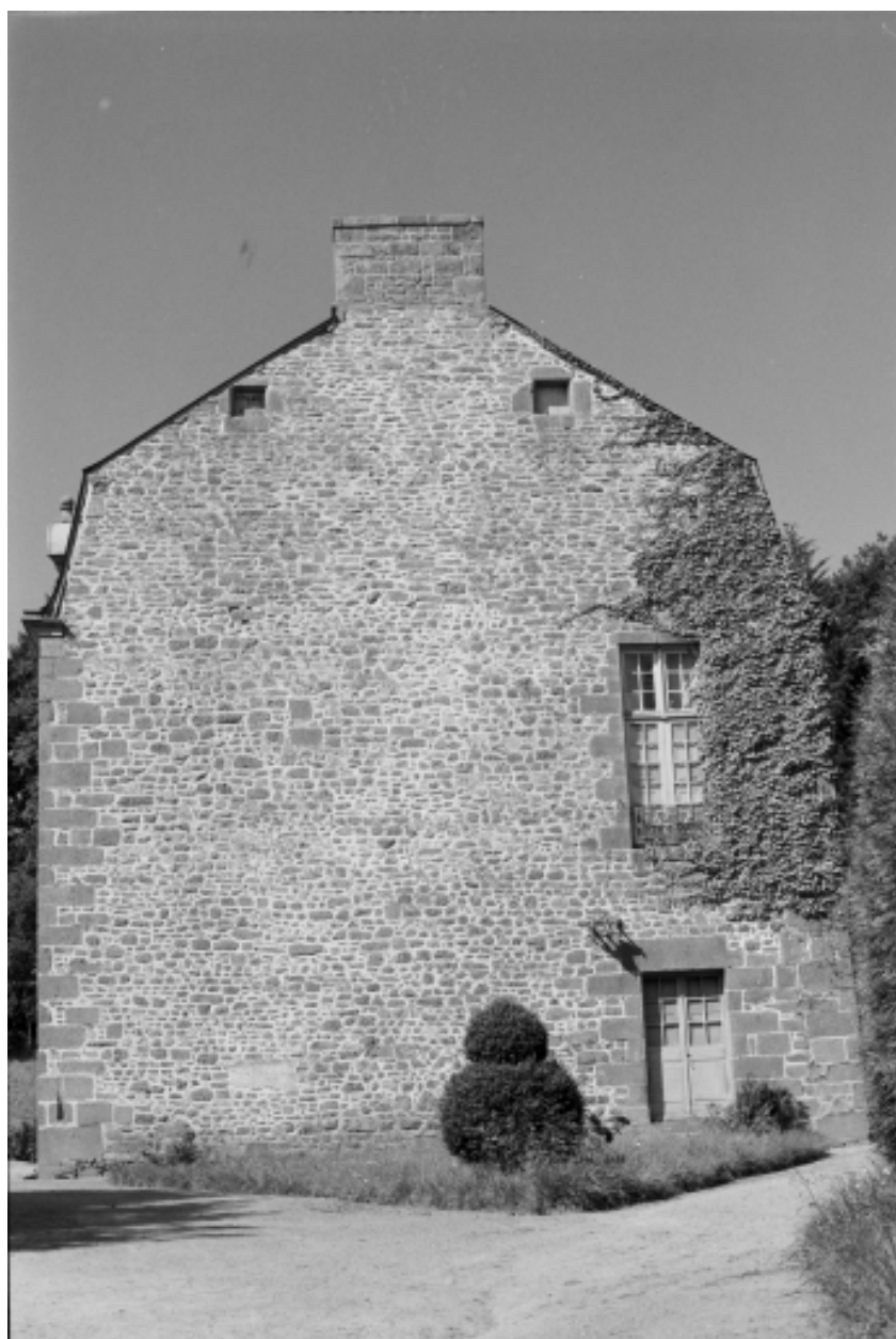
Vue du pignon est du logis.
