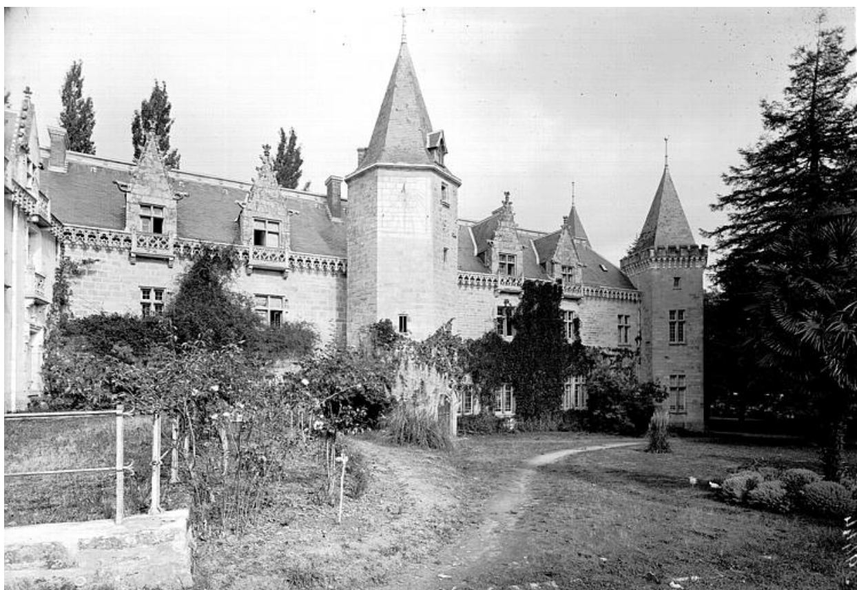
Vue générale façade sud du logis
