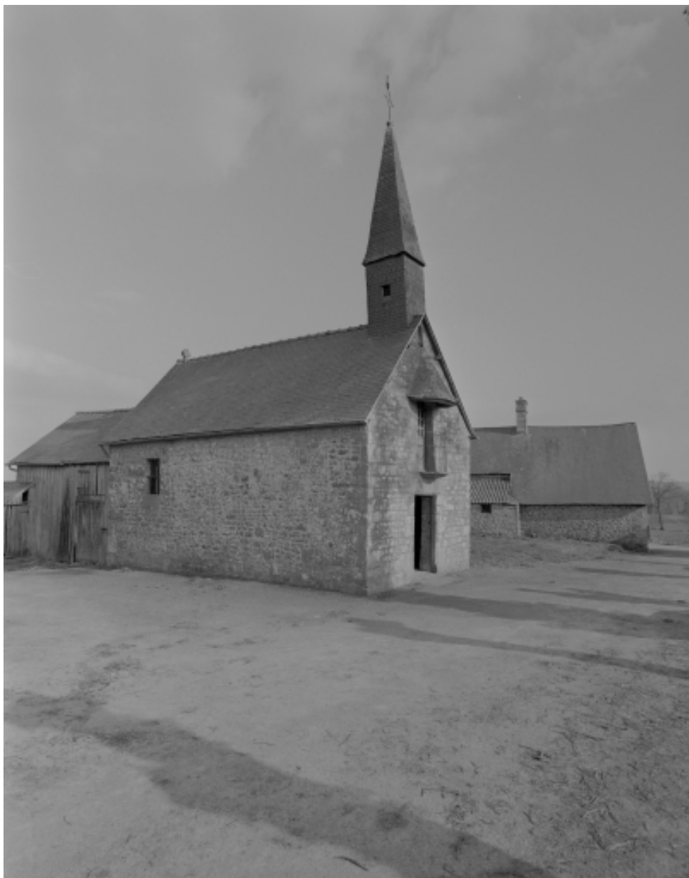
Elévation Nord-Ouest : vue générale
