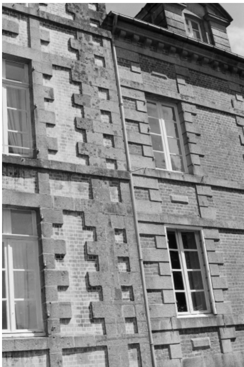
Détail du chaînage d'angle
