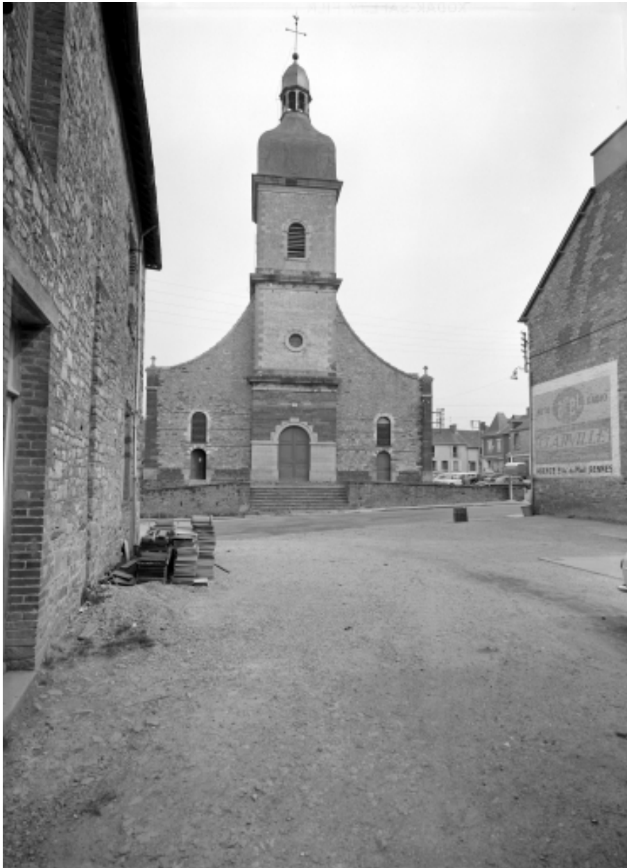
Elévation ouest : vue générale
