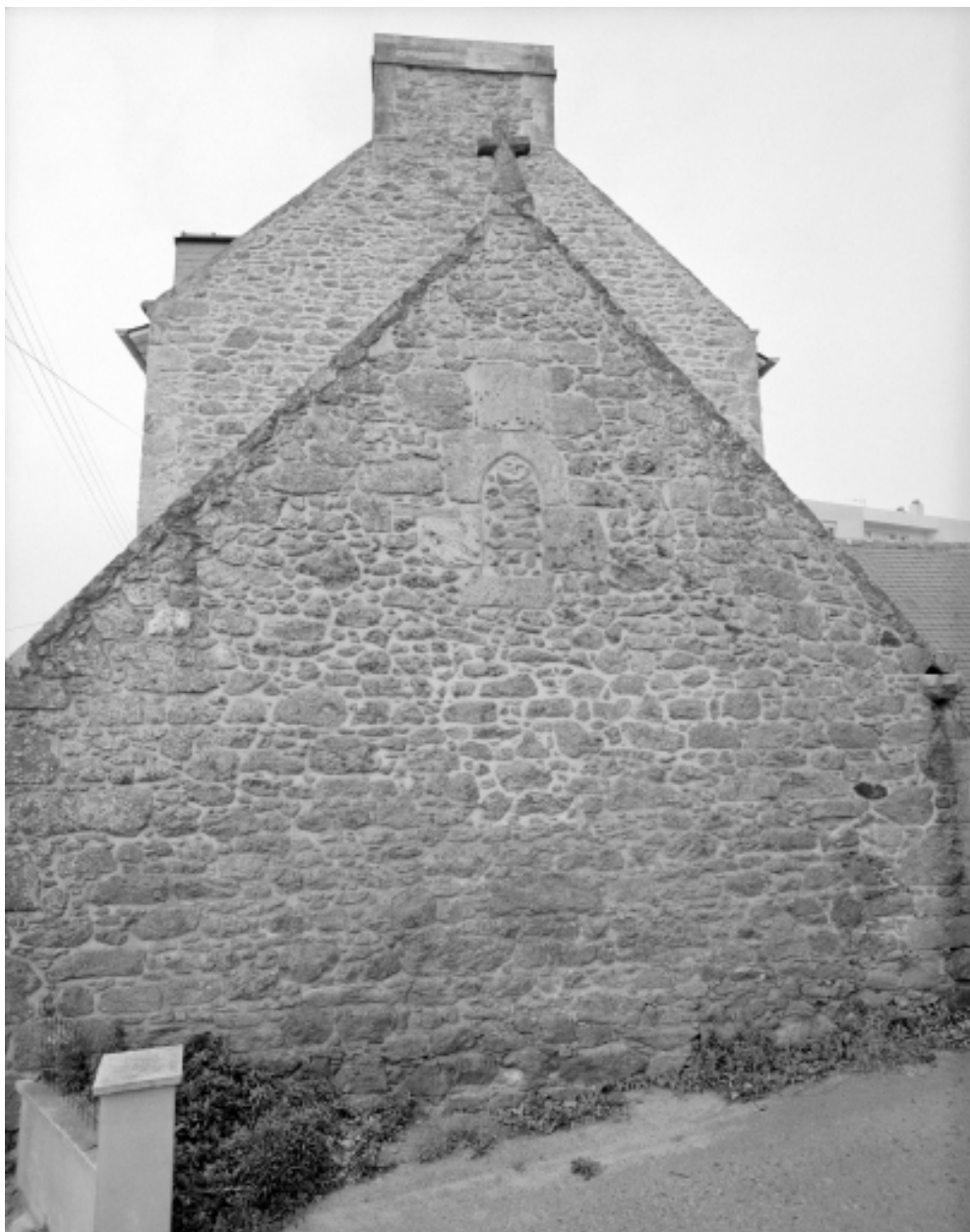
Elévation Est : vue générale
