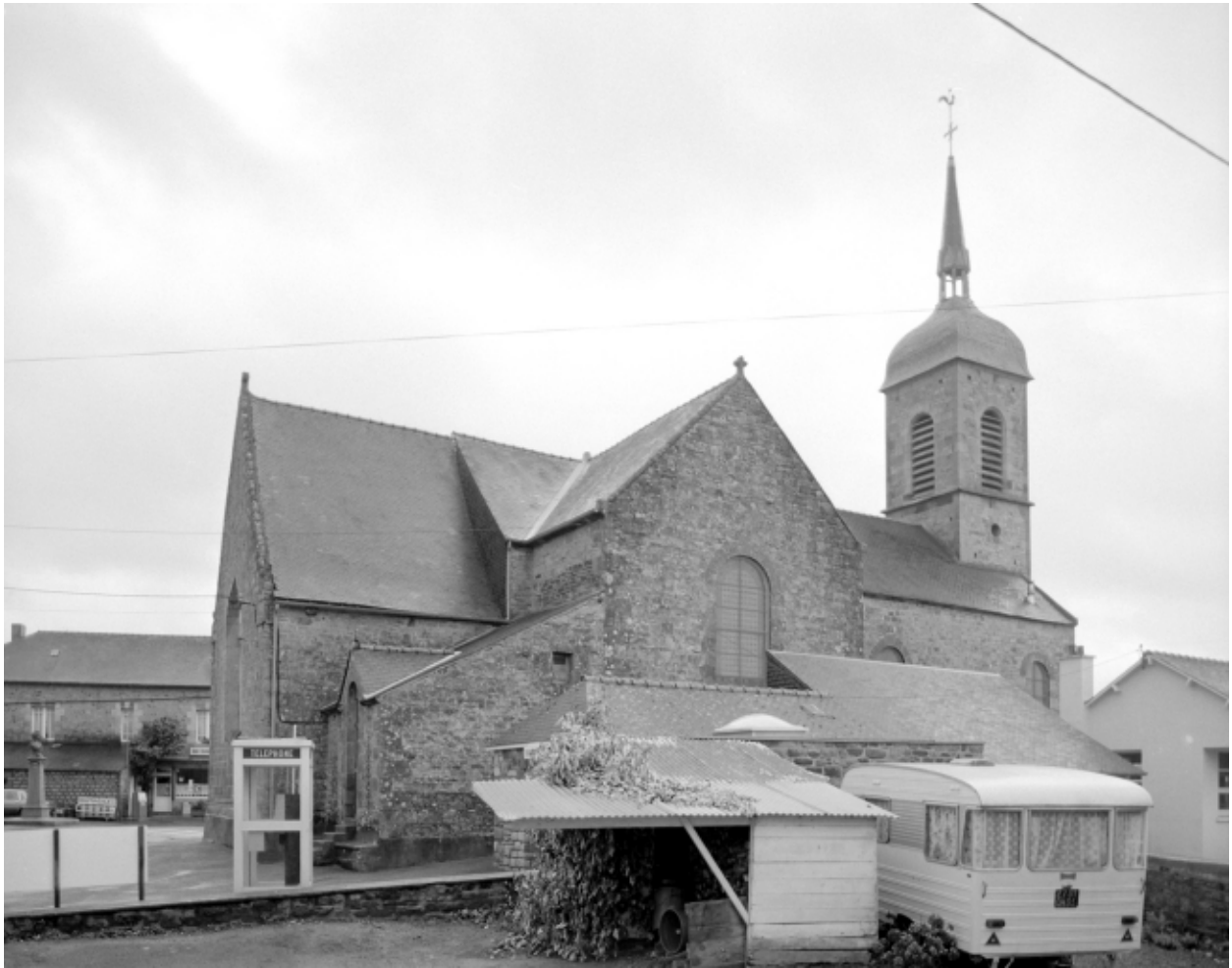
Elévation nord : vue générale
