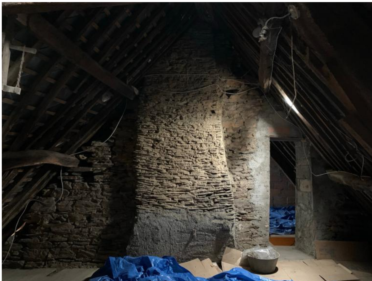
Combles avec cheminée
