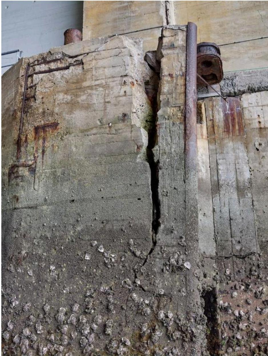
Vue de l'entrée de l'alvéole D : entrée du quai n° 19 est montrant le vieillissement du béton armé
