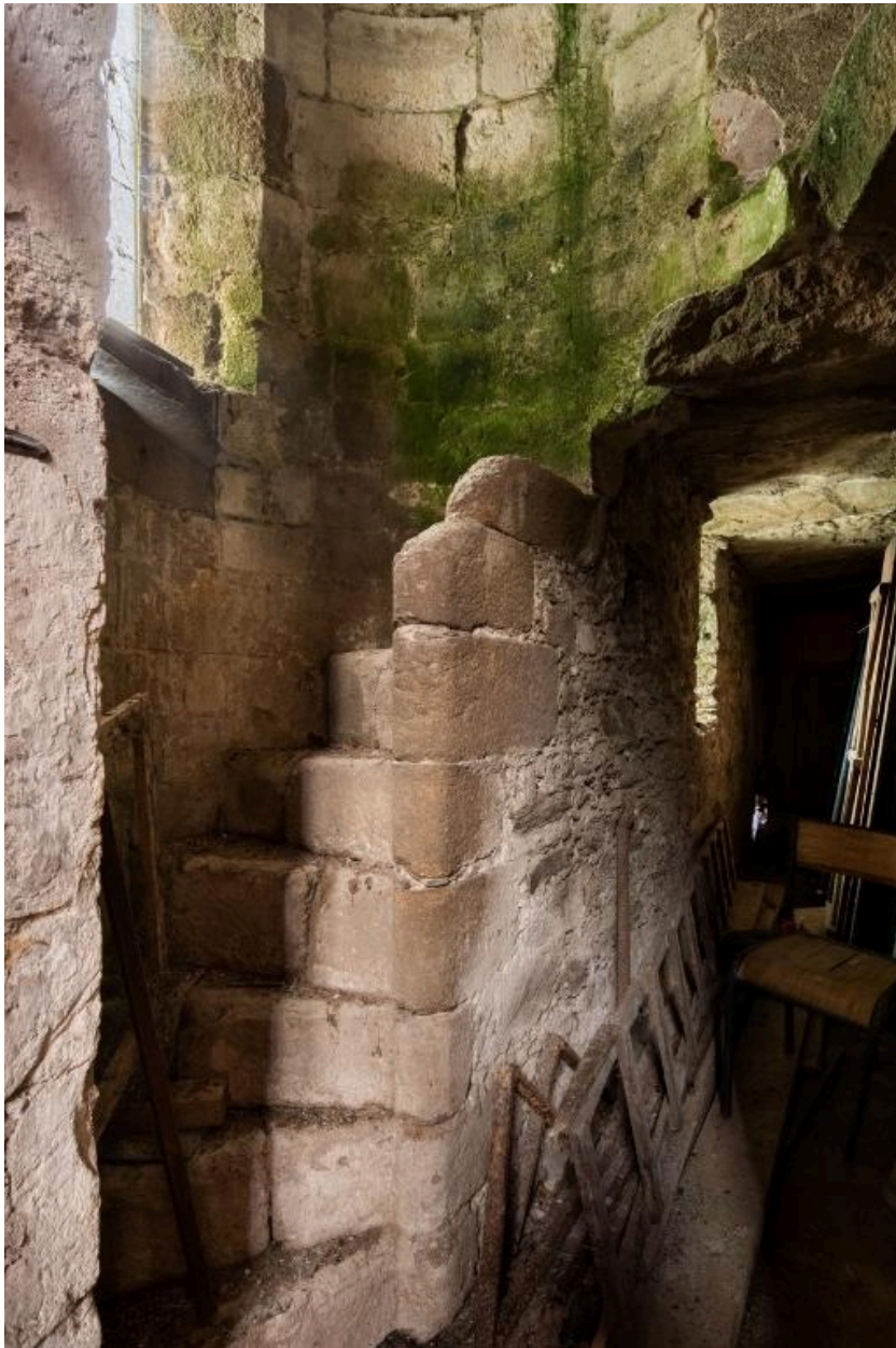
Elevation ouest, détail d'un escalier en vis
