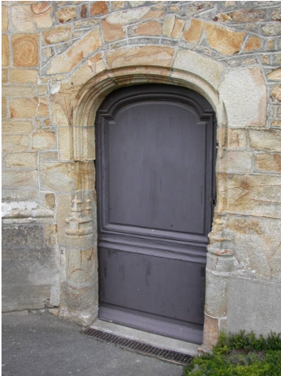
Porte de la façade sud-ouest
