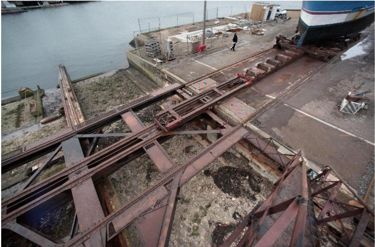
Plate-forme et chariot : le système de levage est situé sur la passerelle.
