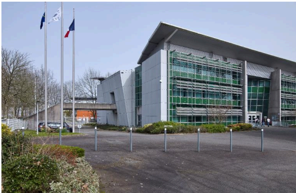
Vue partielle du bâtiment principal, prise du sud-ouest. Joël Y. Gautier, architecte, 1992.
