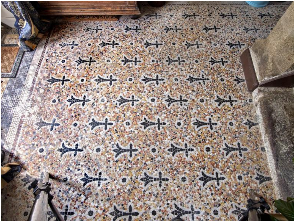
Revêtement de sol en mosaïque du hall d'entrée.
