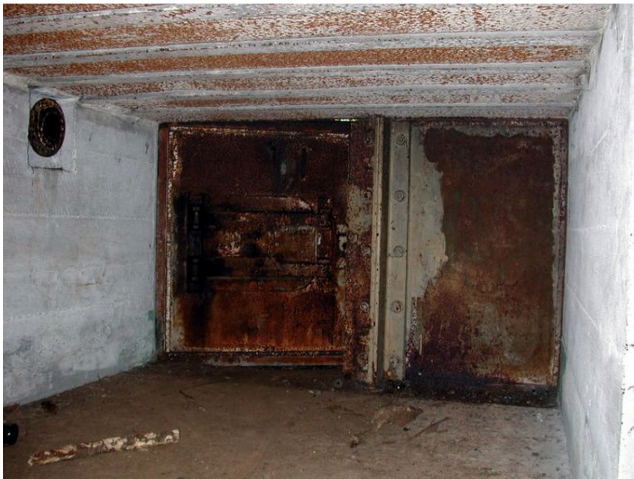
Vue intérieure : porte blindée de type 447P01 de la chambre de combat (état en 2002)
