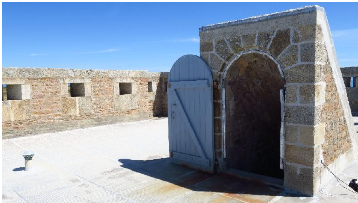
Île-d'Houat, batterie du Béniguet, corps de garde crénelé, terrasse.
