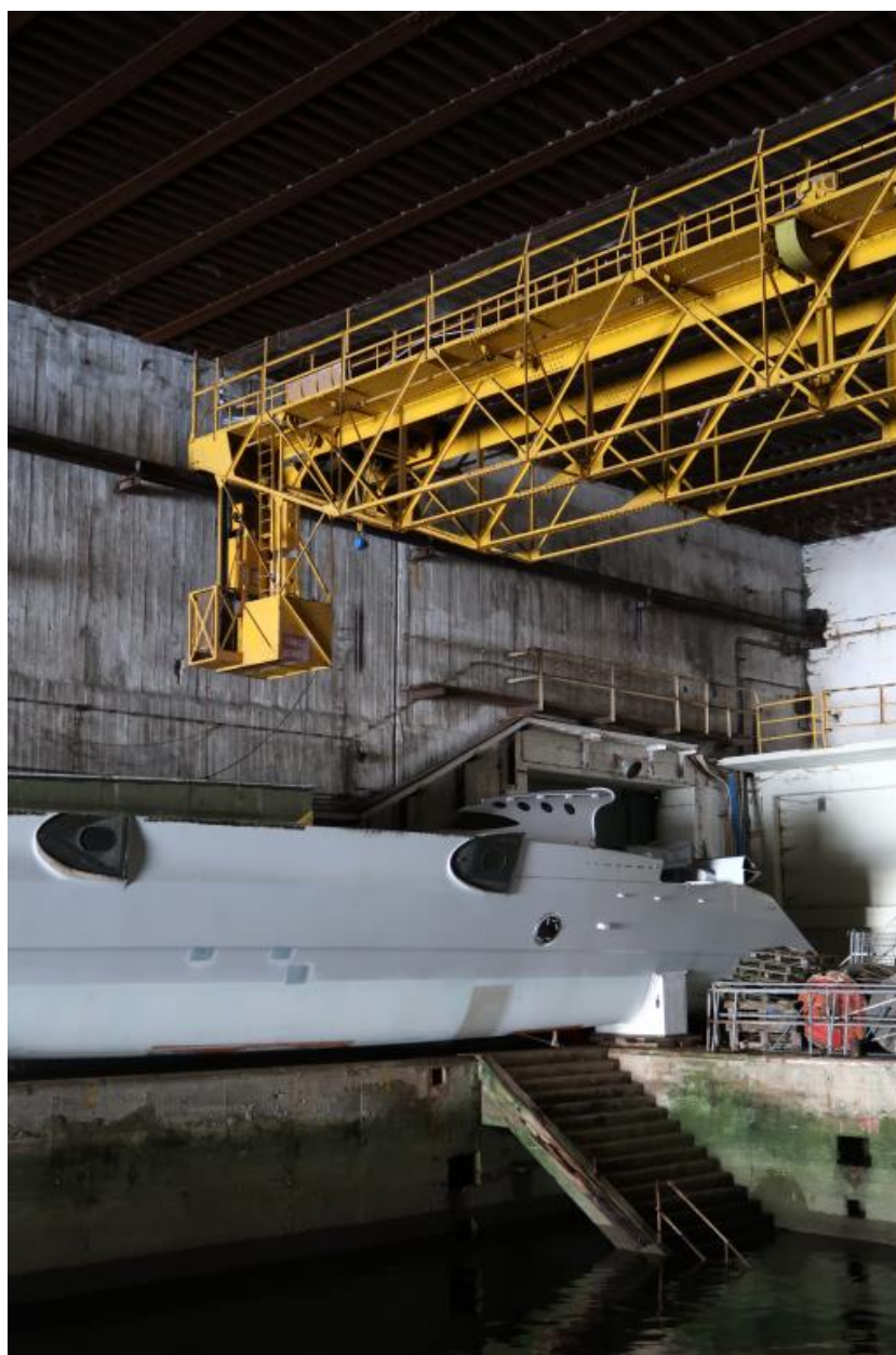
Vue du pont roulant de l'alvéole nord depuis le quai central (état en 2023). Sur le quai nord, la coque centrale du trimaran Oman Air
