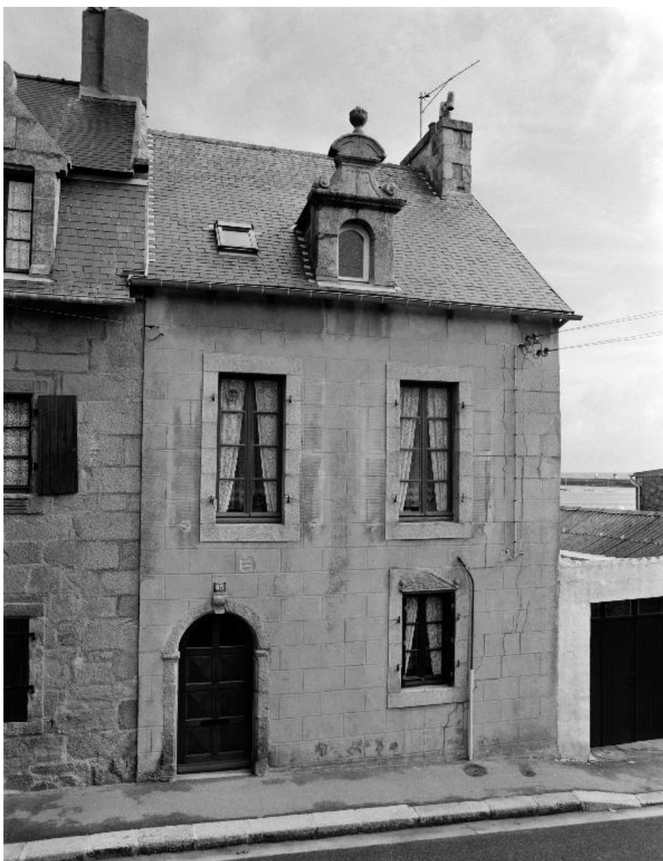
45 rue Amiral Courbet, élévation sud, vue générale
