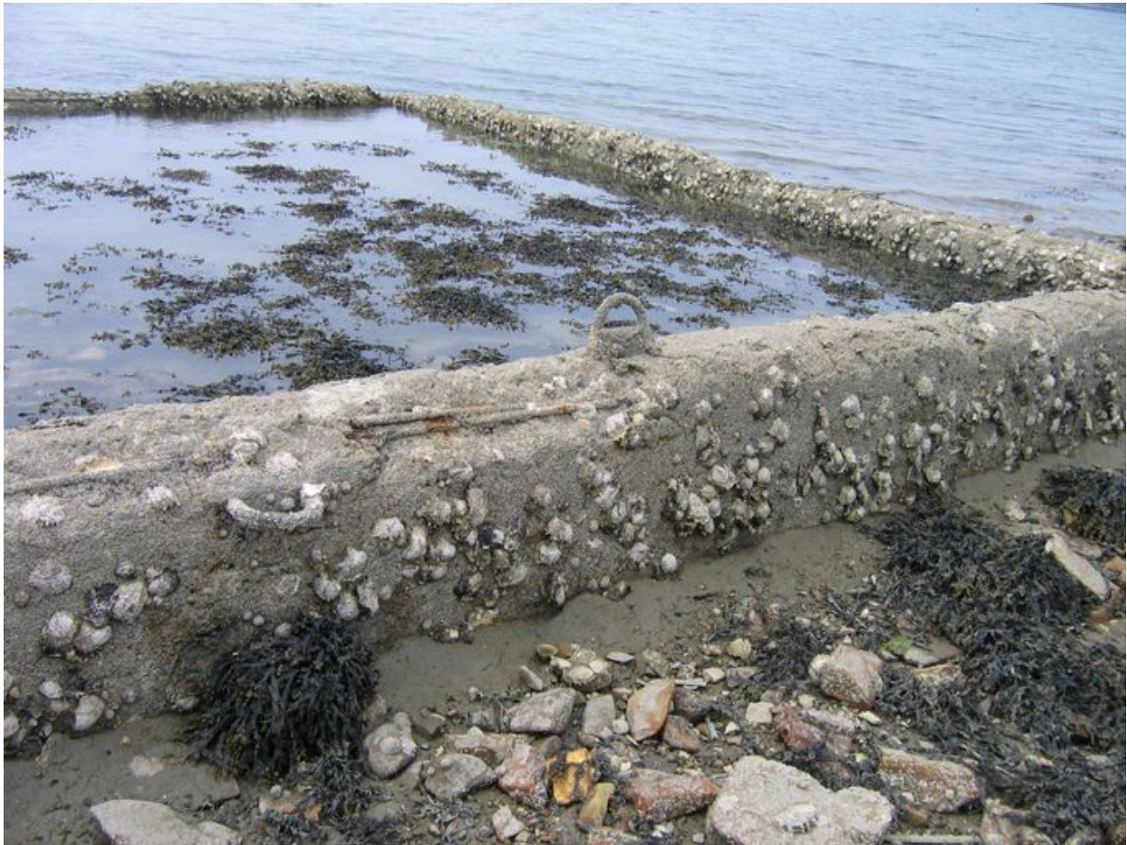
Bassin de décantation à huîtres
