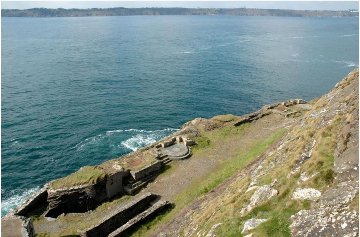
Vue générale de la batterie de l'îlot des Capucins. Derrière le parapet grossier en schiste, on distingue trois plateformes bétonnées pour canon dont deux similaires pour un canon G de 95 mm de côte
