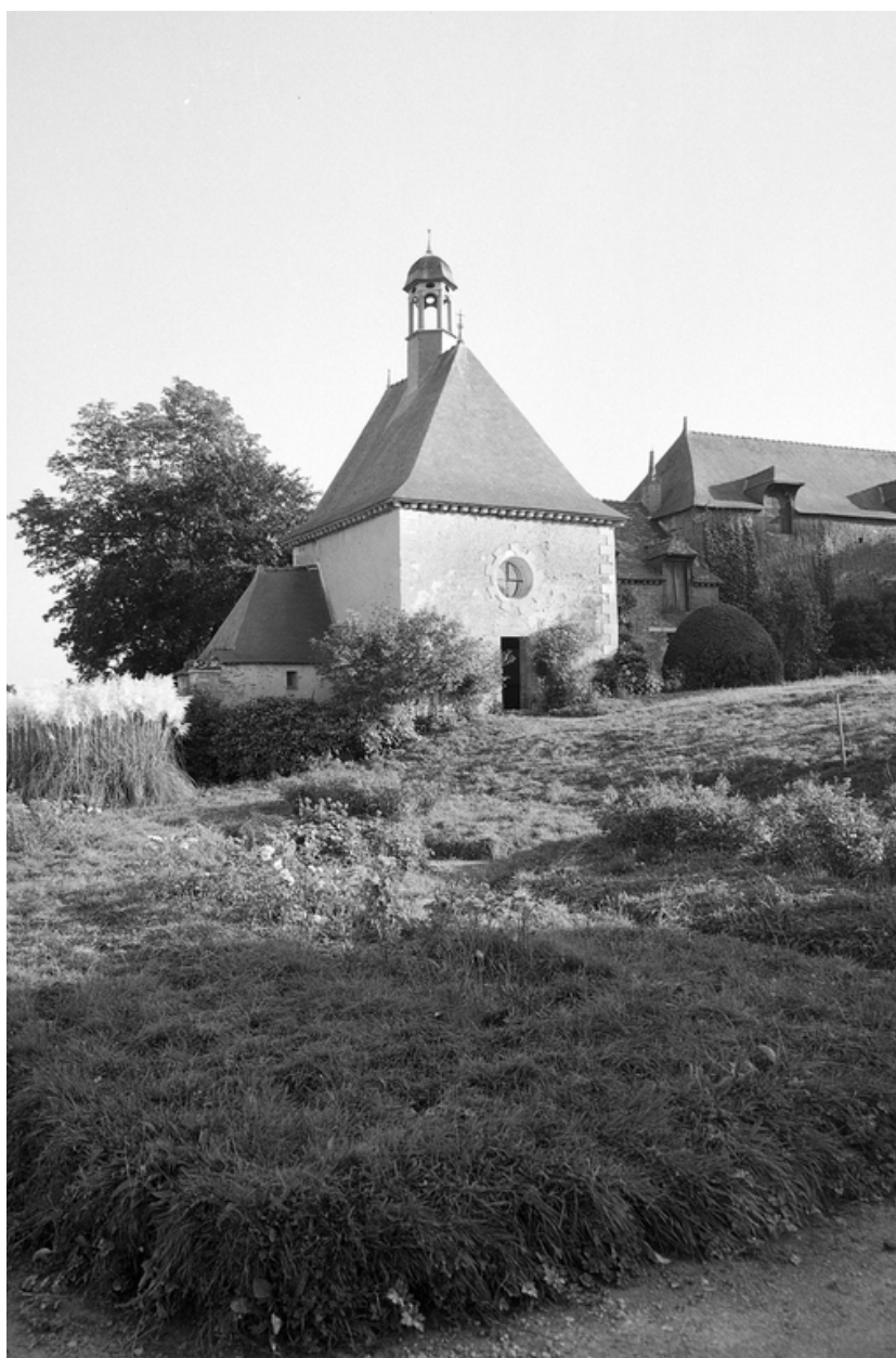
Chapelle, vue générale nord est.
