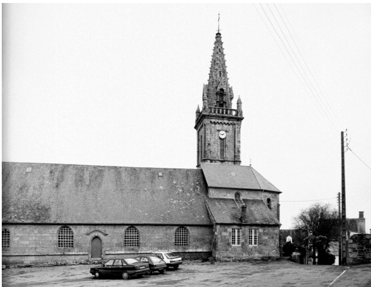
Elévation Sud, partie Est : vue générale
