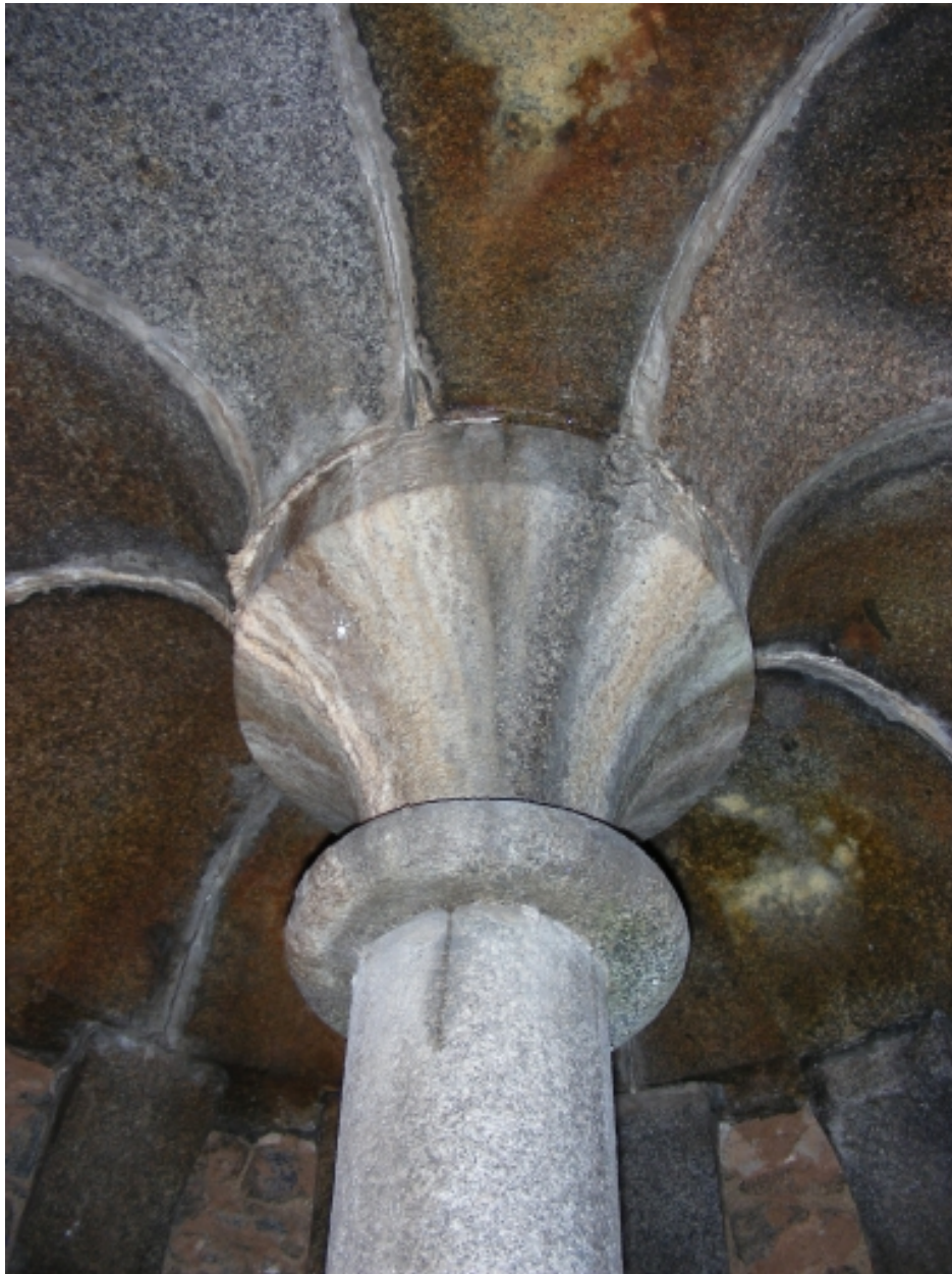
Voûte en granite dans la tour sud
