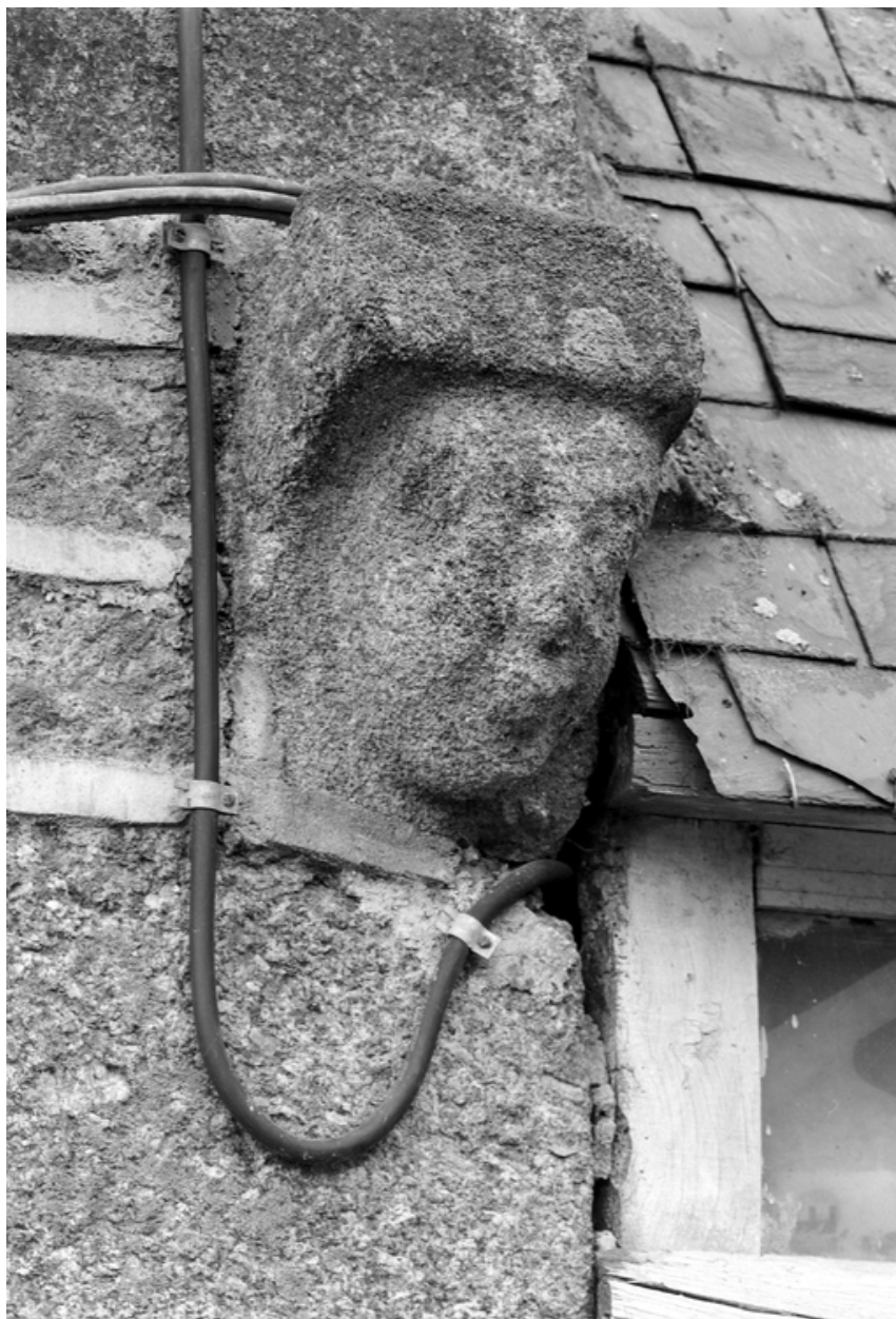
Maison (Kergadiou) : façade sud, détail : tête sculptée à l'angle sud-est
