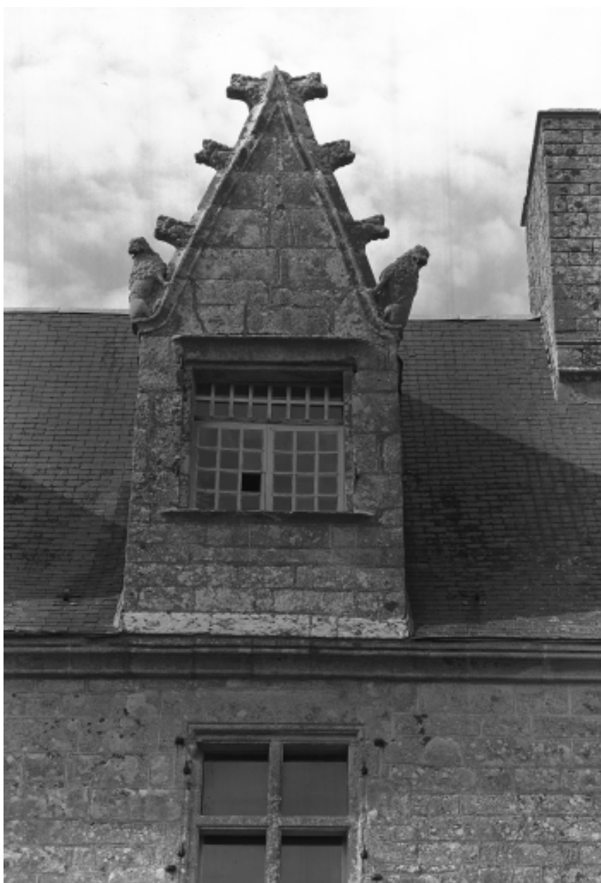
Façade sud : détail de la troisième lucarne ouest est
