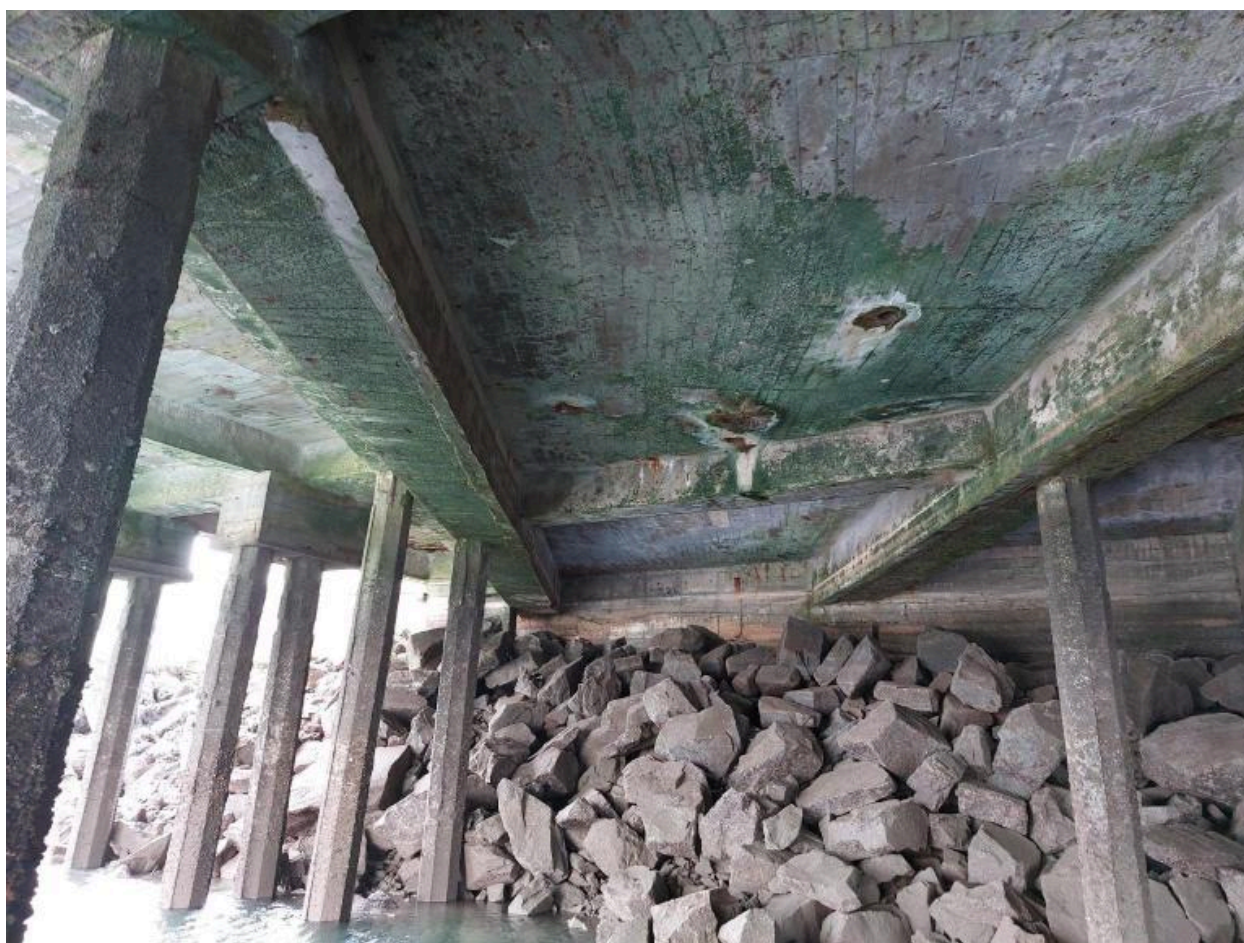
Structure du quai minéralier : plate-forme béton armé, pieux béton, enrochement
