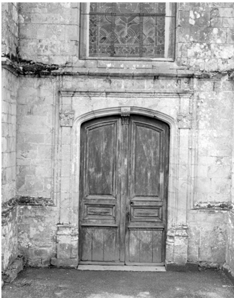
Façade nord, portail
