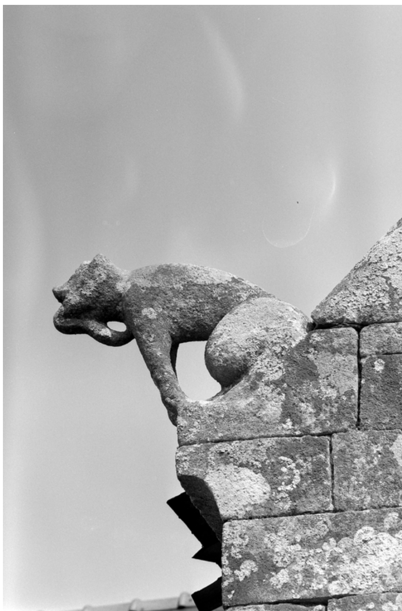
Croisillon sud : détail de la pierre d'assise sculptée du rampant ouest
