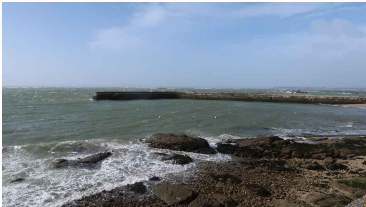
Môle de la Croix, vue générale, tempête du 28 mars 2024
