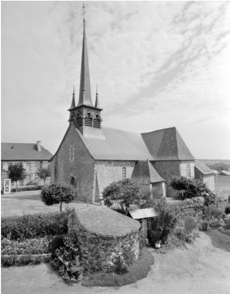
Elévation sud-ouest : vue générale
