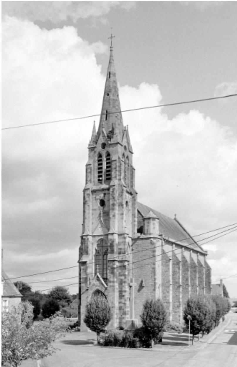
Elévation Ouest : vue générale
