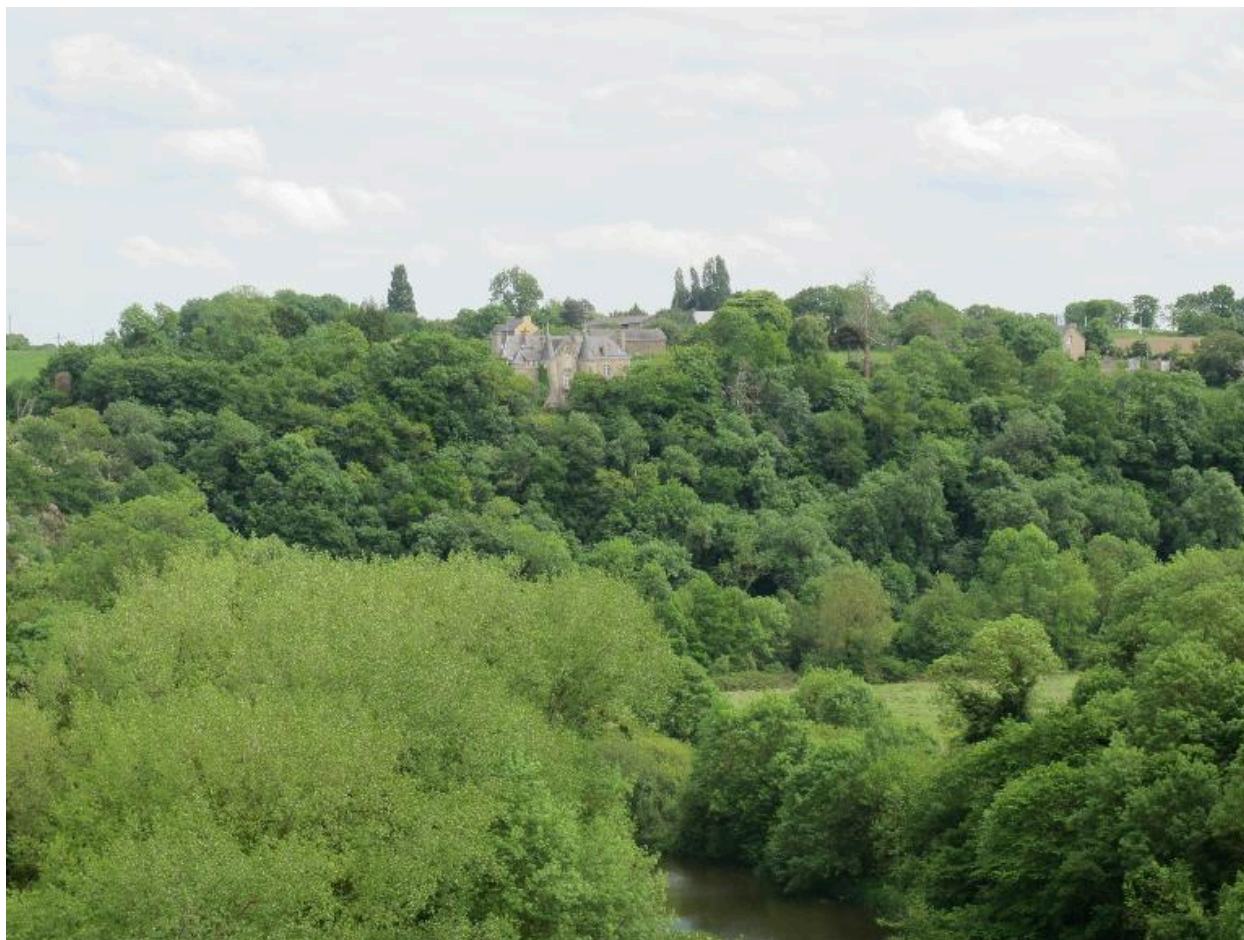
Vue de situation, prise de Taden, façade arrière donnant sur la Rance
