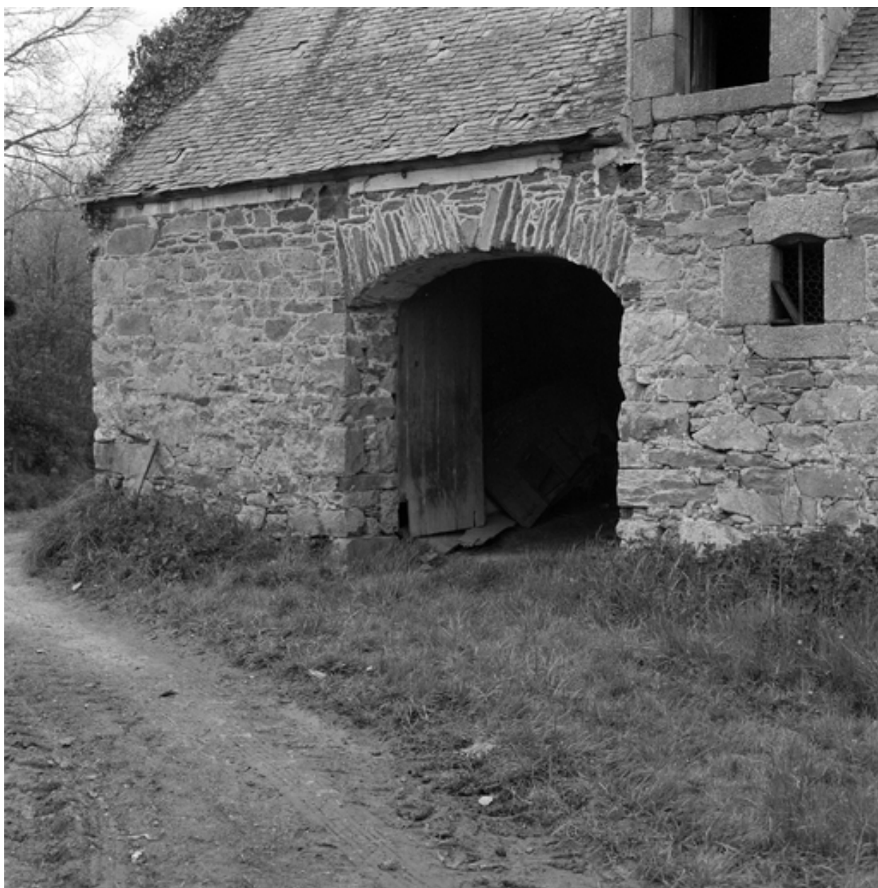
Dépendances, détail : porte charrettière (état en 1974).
