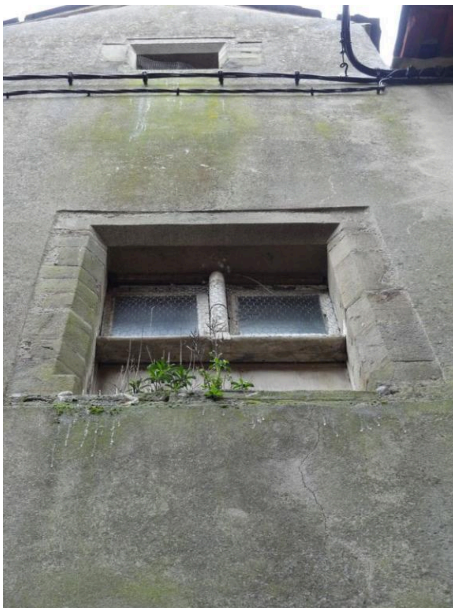
Fenêtre du premier étage de la façade ouest
