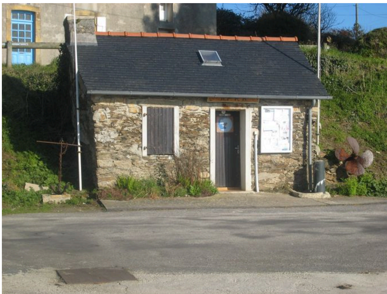
Vue générale de la maison du douanier
